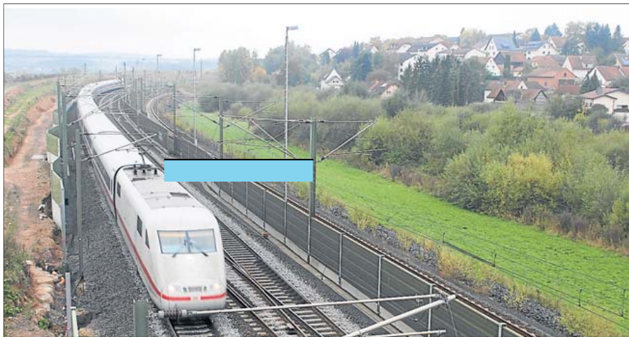
Auf der bestehenden Bahntrasse von Frankfurt nach Fulda durch Neuhof fahren bereits ICES – allerdings nicht mit 200 Kilometer pro Stunde. Foto: Corinna Hiss
