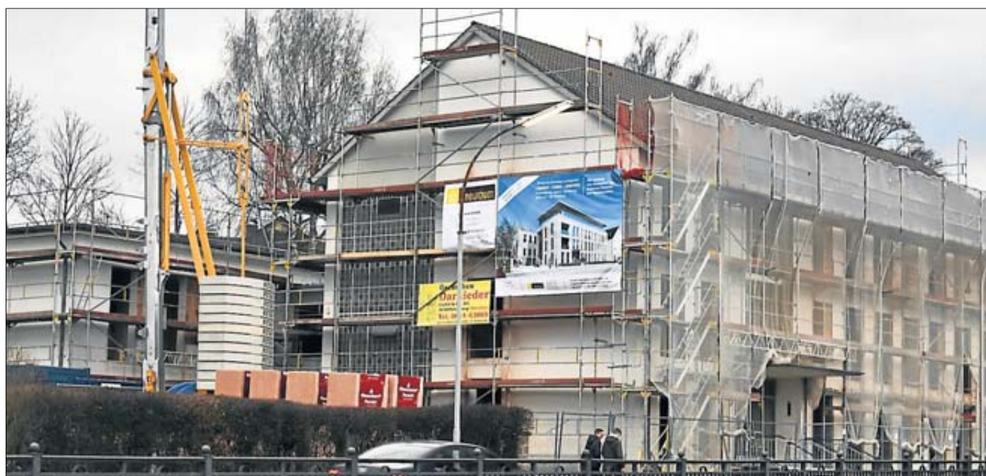
Das ehemalige Amtsgericht Lauterbach wird seit Wochen saniert und umgebaut. Im Juni 2017 soll dort die Hochschule Vogelsberg einziehen. Foto: Walter Kreuzer
