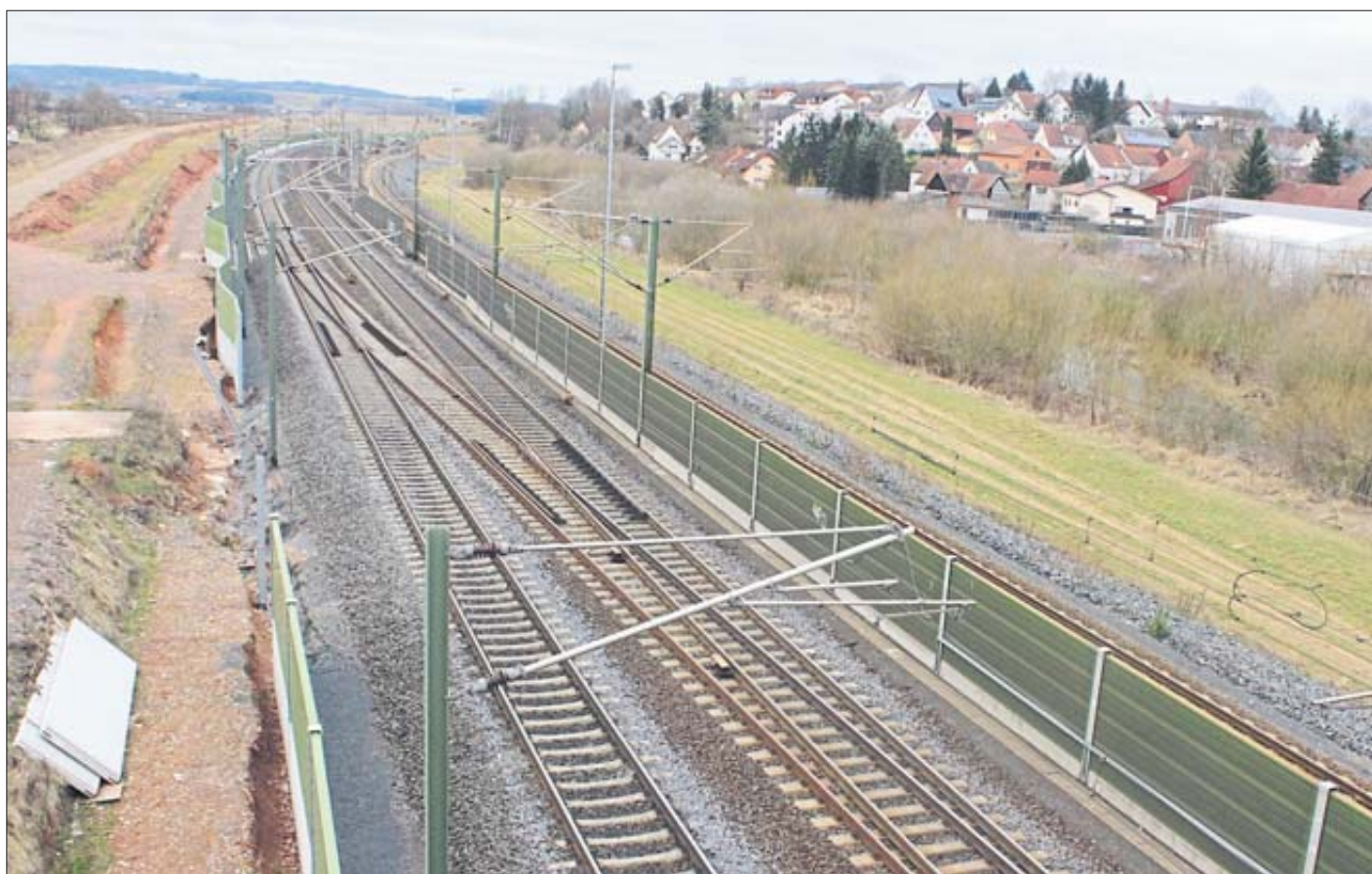
In der Diskussion um den Bahnausbau prüfen die Planer unter anderem die sogenannte Variante V entlang der Bestandsstrecke. In Neuhoof wäre für einen Gleisausbau genügend Platz, bestätigt die Bahn. Foto: Corinna Hiss
